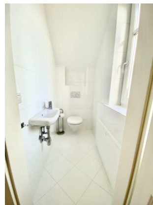
separates WC im OG
